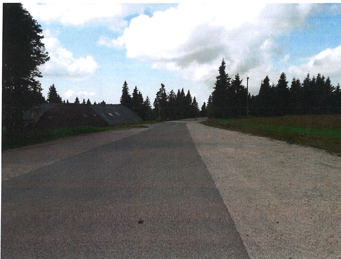
Slika 1: začetek odseka v km 2.850 (pogled v smeri stacionaže)
