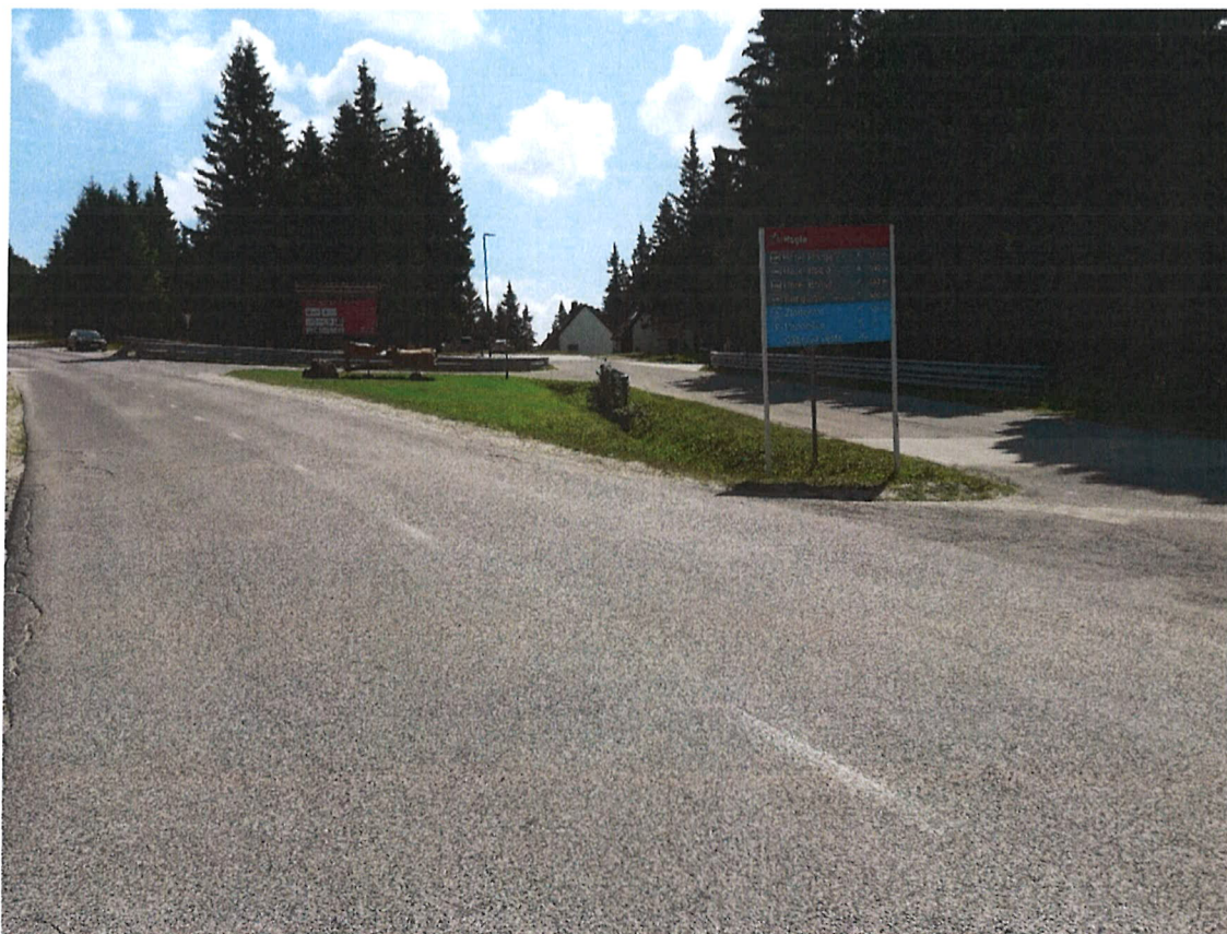
Slika 4: križišče v km 3.700 (pogled proti Rogli)
