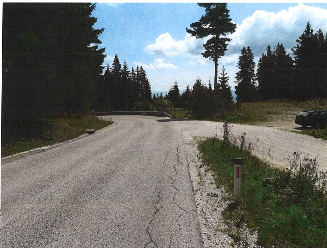
Slika 6: konec odseka-priključek v km 5.500 (pogled proti Zrečam)
